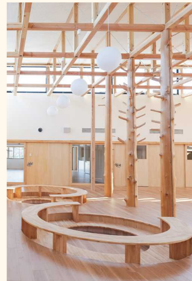
■松の枝付きのシンボルツリーが空間に遊び心を加えています。その他の構造材は奈良県産の杉と桧のJAS機械等級の製材品です。
